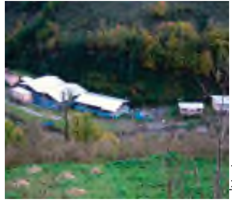
Su arıtma tesisi
