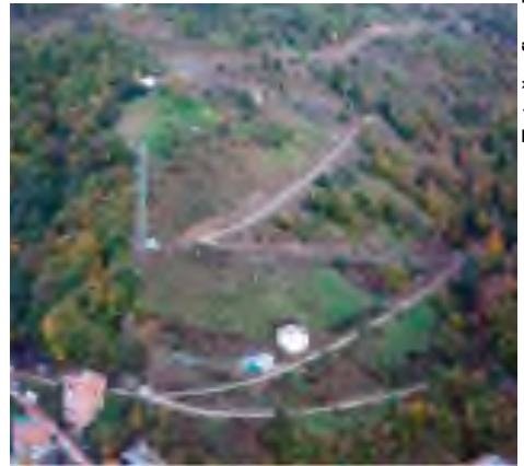
Çam kiriş mahallesine 2200 m yeni yol
