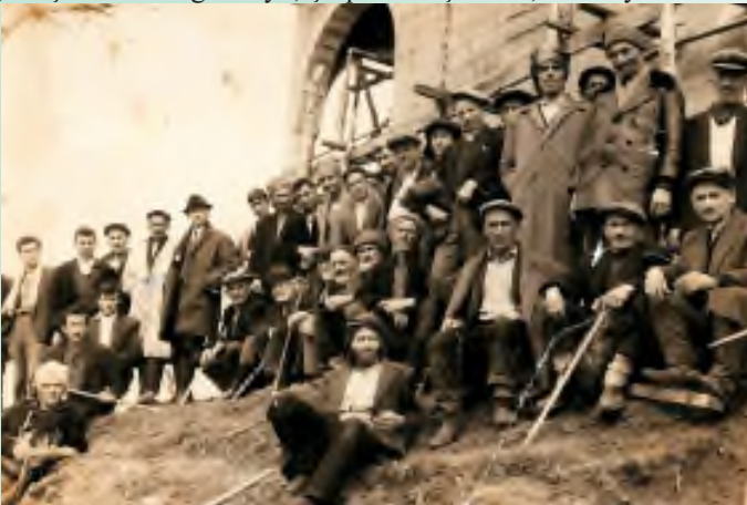
Kasımağzı köylüleri, köylerine elbirlikle yapmakta oldukları caminin inşaatının önünde. (1965)
